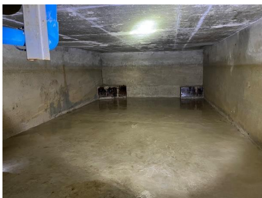
ภาพที่ 2-7 ถังเก็บน้ำใช้ และการล้างทำความสะอาดถังเก็บน้ำใช้
